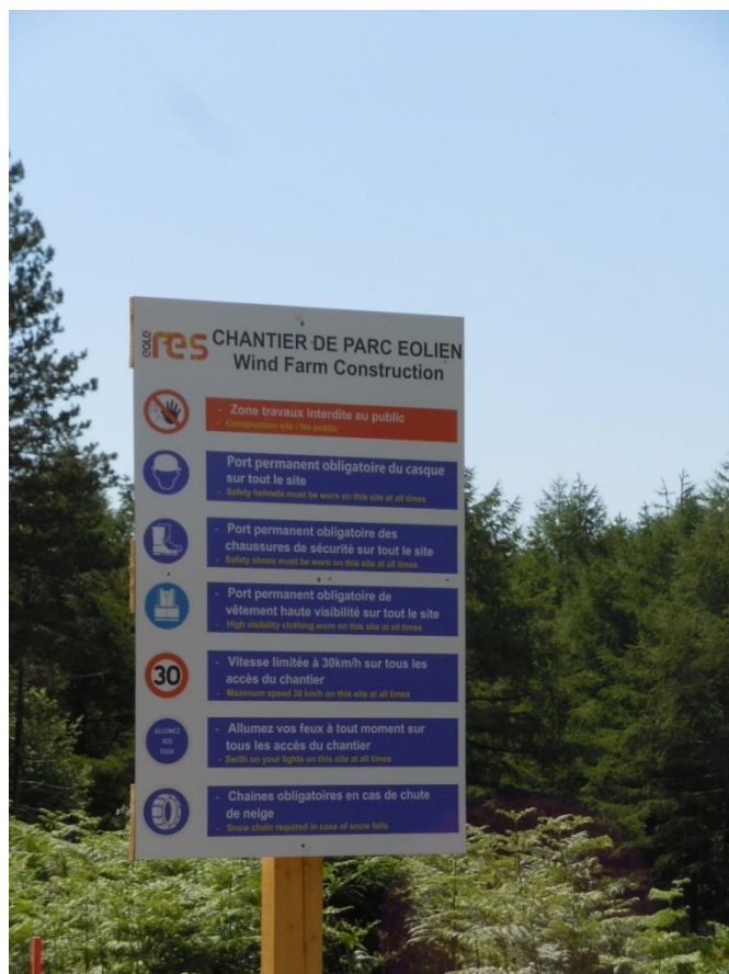
Photographie 1 : Exemple de signalétique en phase chantier (source : RES)
