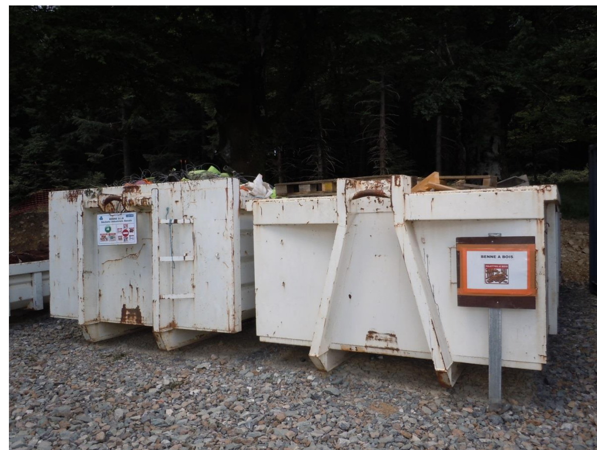
Photographie 2 : Exemple de bennes installées sur le chantier
